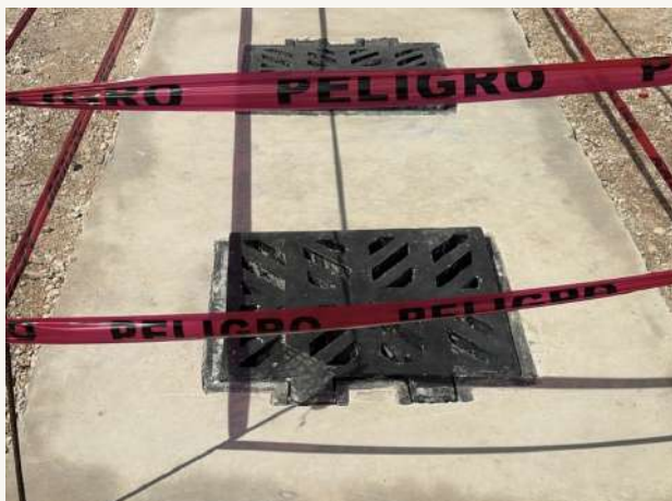
03 • Instalaciones hidrosanitarias y drenaje pluvial
