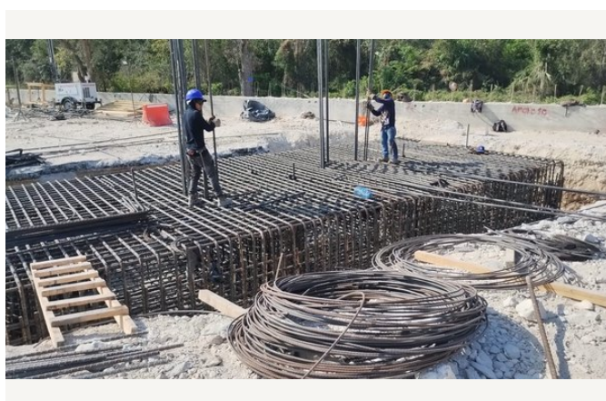
Habilitado de acero de refuerzo.
